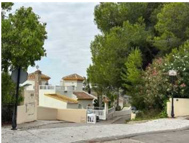
Ilustración 18. Imagen del acceso a la Calle Comedias sin señalización de calle sin salida.
